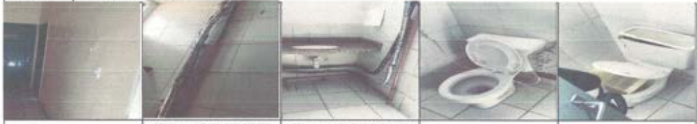
TRATAMENTO DE UMIDADE, PINTURA REBOCO NA ALVENARIA PARA EMBUITE, INSTALAÇÃO DE ARGOMOSADO, TROCA DO REVESTIMENTO CERÂMICO REBOCO NA ALVENARIA PARA EMBUITE, INSTALAÇÃO DE ARGOMOSADO, TROCA DO REVESTIMENTO CERÂMICO TROCA DE VAZO E ACESSÓRIOS TROCA DE VAZO E ACESSÓRIOS
